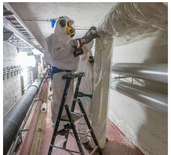
Säkitetyn massaputkieristeen purku parityöskentelynä käyttämällä imuria kohdepoistona eristeen leikkauskohdassa.
