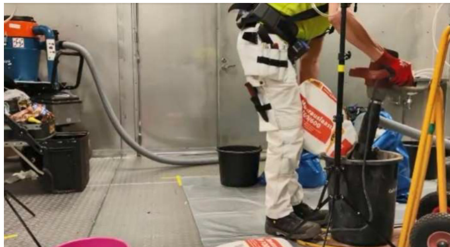
KUVA 2. Sekoittajiin suunniteltu laitekohtainen kohdepoisto (huuva).
