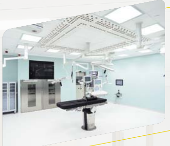
Vuonna 2020 valmistuneessa Jyväskylän Sairaala Novan leikkaussaleissa hyvä ääniympäristö toteutettiin partikkeleita hylkivillä Ecophon Protec A akustiikkalevyillä.
